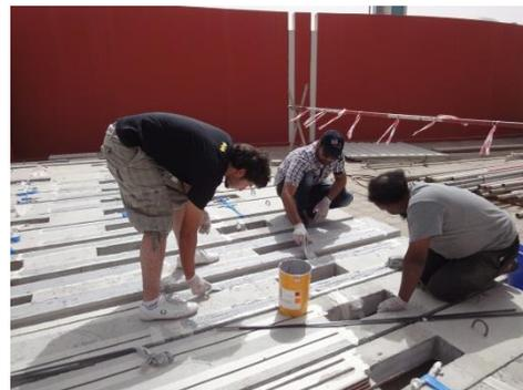
(d) Installation of epoxy adhesive
