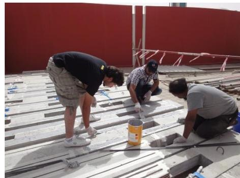
(d) Installation of epoxy adhesive
